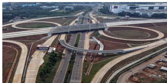
Gambar 5 Jalan Tol Serpong
