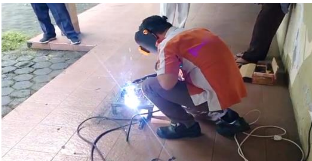
Gambar 4. Mengelas Menggunakan APD
