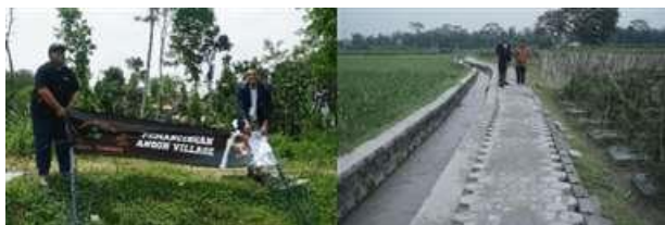
Gambar 1. Pembangunan jalan dan gapura di Embung Pemancingan.
