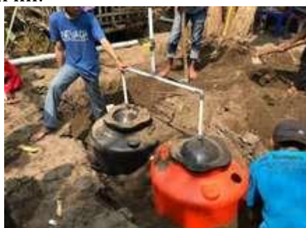
Gambar 12. Pemasangan Alat Biogas.
