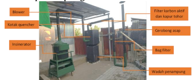
Gambar 4. Komponen Sistem Filter Sampah untuk Insinerator Bank Sampah.
